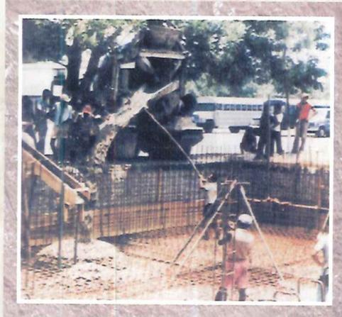
Se realiza la construcción de los tanques subterráneos con la suficiente capacidad para almacenar grandes cantidades de agua para uso del personal, ofreciendo la posibilidad de tener una reserva cuando se presente suspensión del servicio por parte del acueducto.
